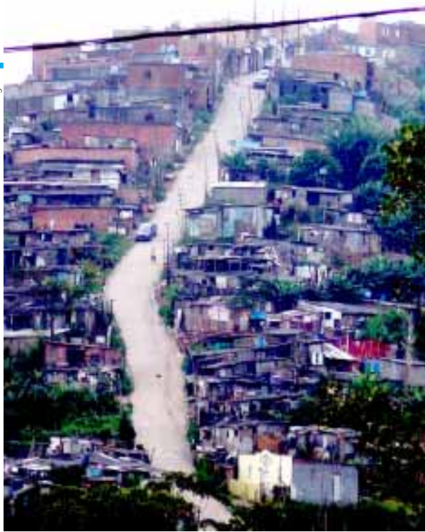
Jardim Silvana: uma favela construída sobre um morro íngreme, classificada como área de risco "muito alto", que só em janeiro teve várias mortes e 400 desabrigados
